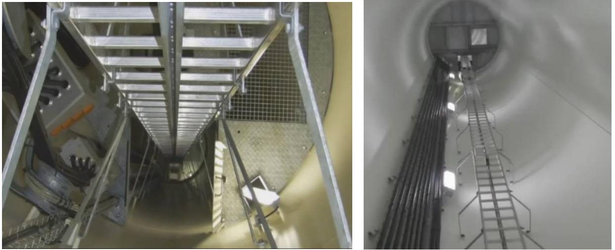
Рисунок 4.29 – Схема компонування циліндричної вежі ВЕУ (вигляд всередині)
