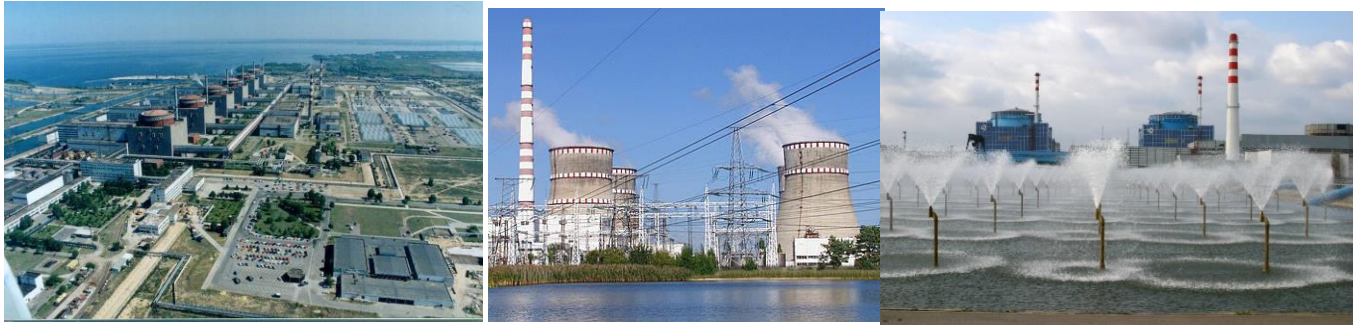
Рисунок 4.16 – Системи охолодження відпрацьованого теплоносія (води) на АЕС: a – промисловий майданчик ЗАЕС із басейнами-охолоджувачами; б – градирні Рівненської АЕС; в – бризкальний басейн Хмельницької АЕС;
