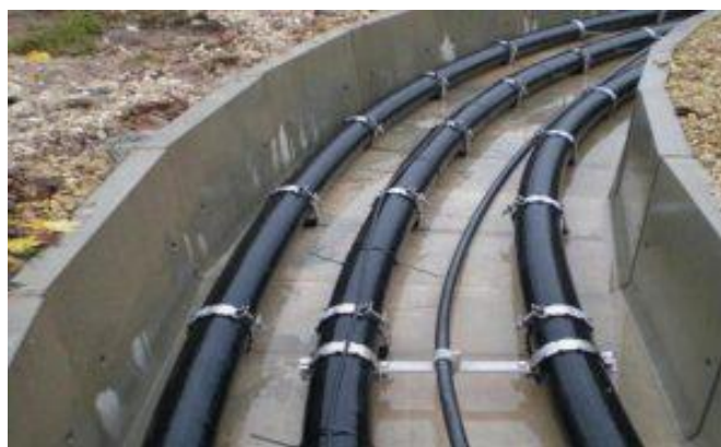
Рисунок 6.15 Прокладка кабелю в кабельному блоку
