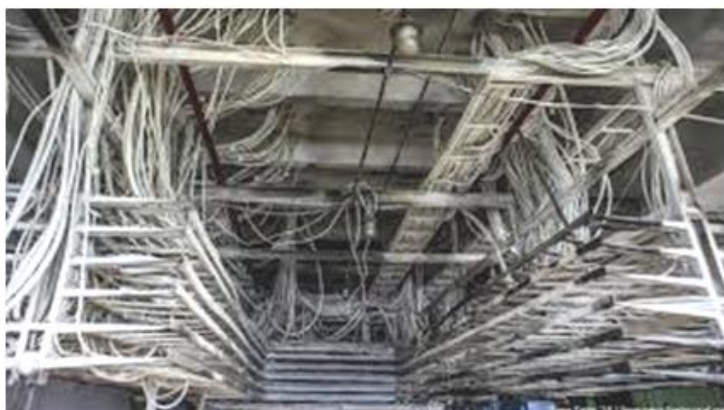
Рисунок 6.14 – Прокладка кабелю по кабельному напівповерху
