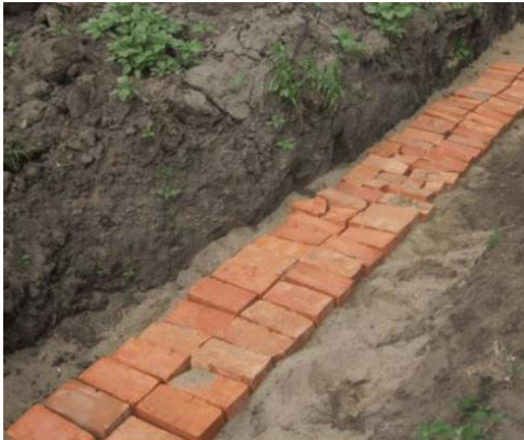
Рисунок 6.9 – Захист кабелю в траншеї червоною цеглою
