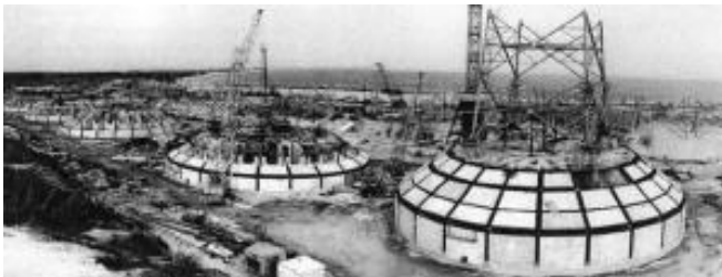
Наплавні фундаменти опор 330 кВ
