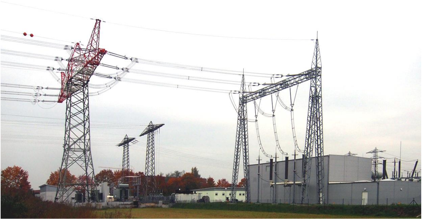
Рисунок 5.10 – Кінцева анкерна опора
