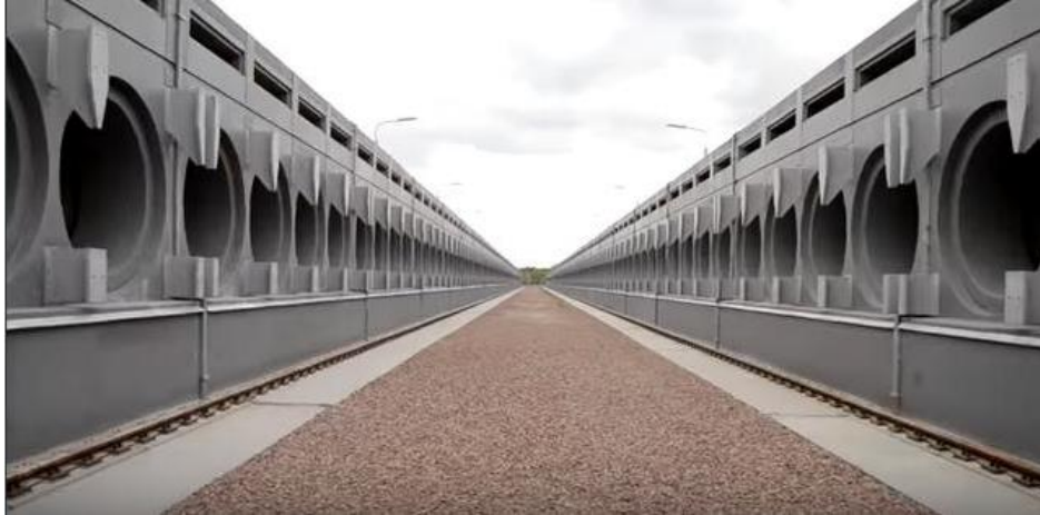
Рисунок 4.21 – ЦСВЯП за технологією сухого модульного зберігання (СВЯП-2) на території ЧАЕС
