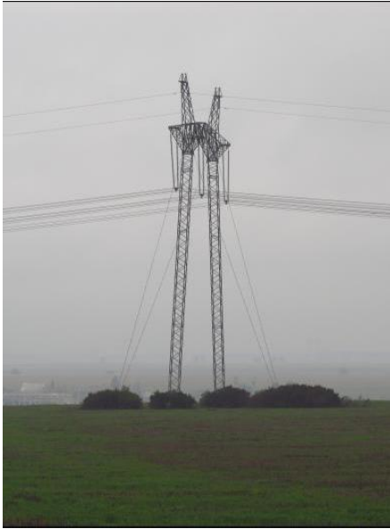
Рисунок 5.3 – Проміжна опора ПЛЕП 750 кВ «Хмельницька АЕС – Жешув (Польща)»
