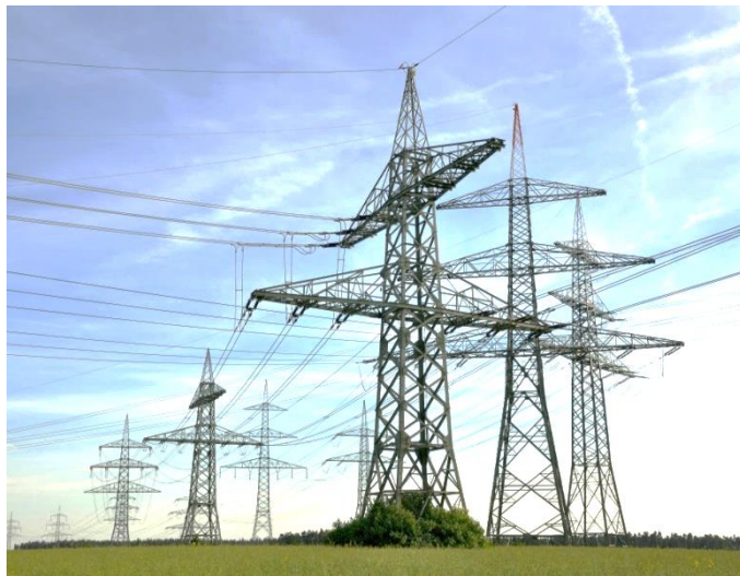
Рисунок 5.7 – Анкерна кутова опора 500 кВ
