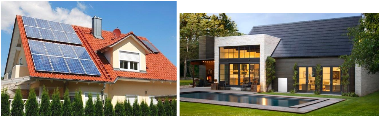
Рисунок 4.46 – Дахи житлових будинків із встановленими сонячними батареями
