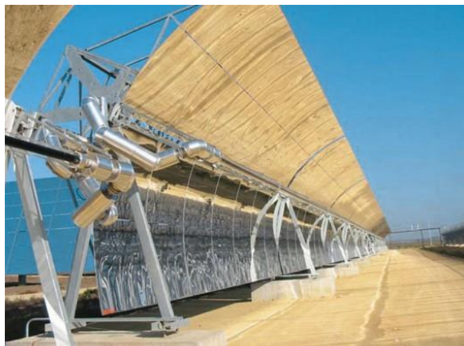
Рисунок 4.41 – Довгі параболічні (у поперечному перерізі) дзеркала-плівки з трубами для розігріву теплоносія (фото Solucar)
