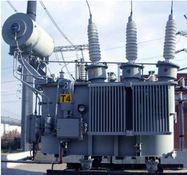
Рисунок 10.2 – Силовий трансформатор із оливним охолодженням потужністю 1000-6300 кВ·А напругою 35 кВ:
