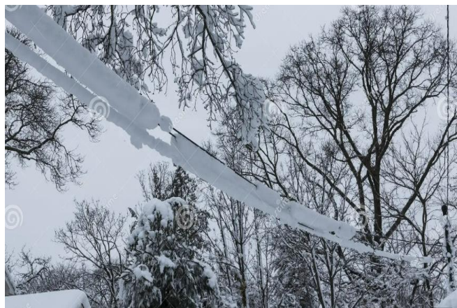
Рисунок 5.13 – Провисання дротів від ваги налипших снігу та інію
