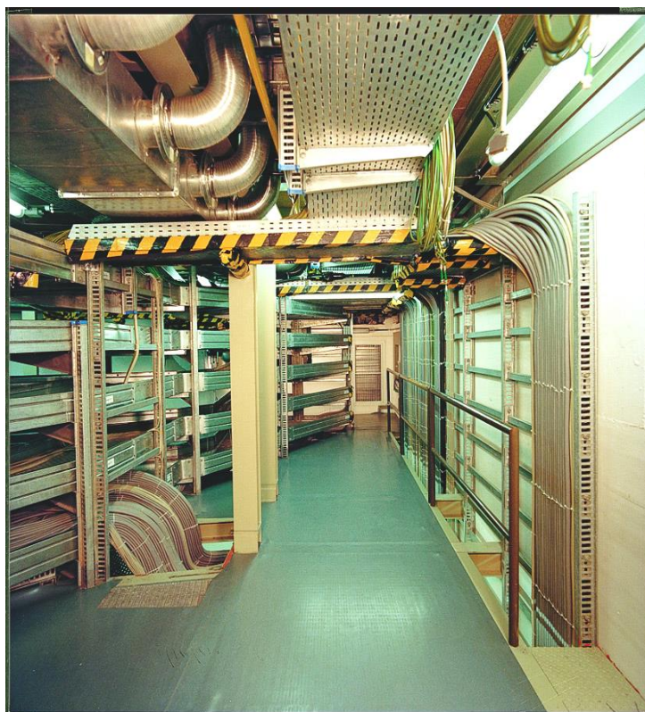
Рисунок 6.13 – Прокладання кабелю по кабельному поверху
