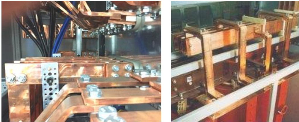
Рисунок 7.19 – Відкритий шинопровід
