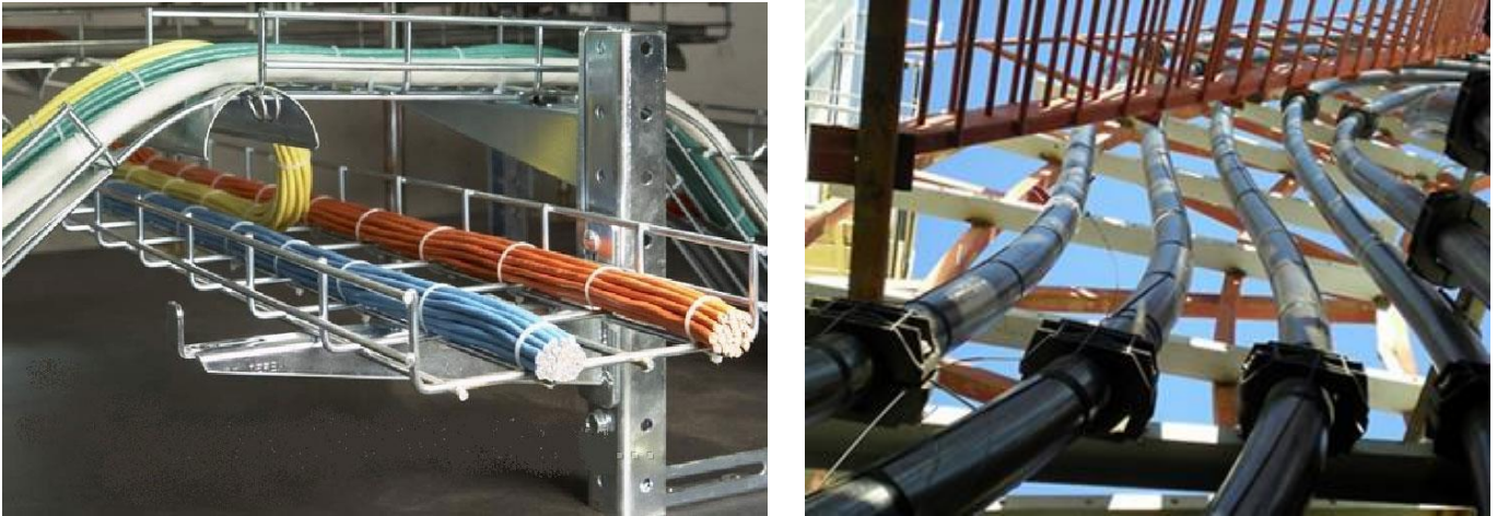
Рисунок 6.16 – Відкрито прокладені кабелі на лотках
