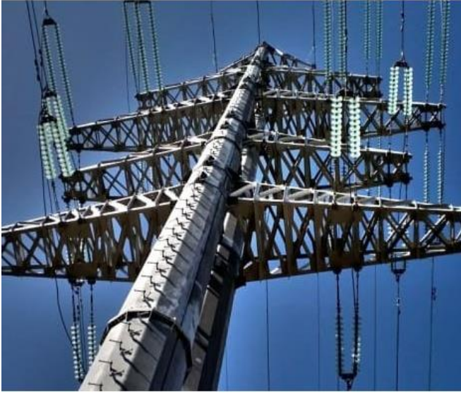
Рисунок 5.20 – Багатогранна металева конічна опора
