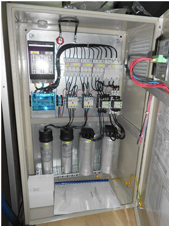
Рисунок 9.1 – Підключення декількох батарей конденсаторів (фото Deer Power , Київ, Україна)
