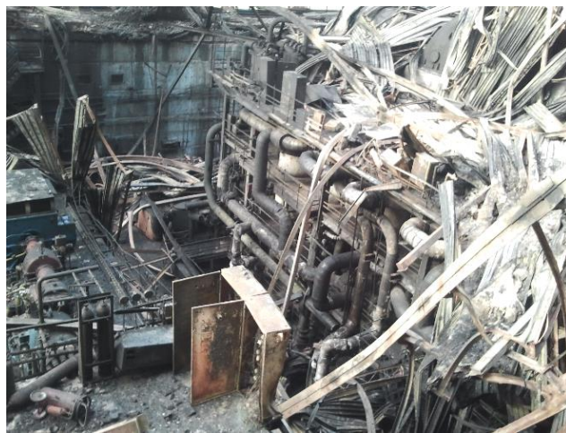
Рисунок 11.1 – Фото пожежі на Вуглегірській ТЕС (а) та вид блоку ТЕС після пожежі (б)
