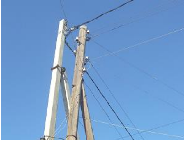
Рисунок 5.5 – Кутова опора 0,4 кВ
