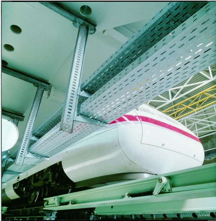
Рисунок 6.17 – Встановлення кабельних ліній на лотках для електрифікованих залізниць та метрополітену
