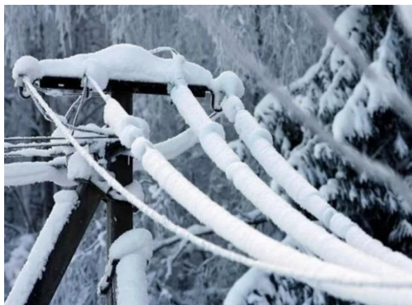
Рисунок 5.13 – Провисання дротів від ваги налипших снігу та інію
