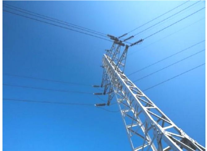
Рисунок 5.6 – Кутова опора 220 кВ
