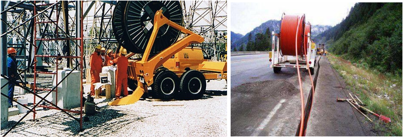
Рисунок 6.18 – Прокладання кабелів в траншеях з кабельних барабанів, встановлених на автомобілях
