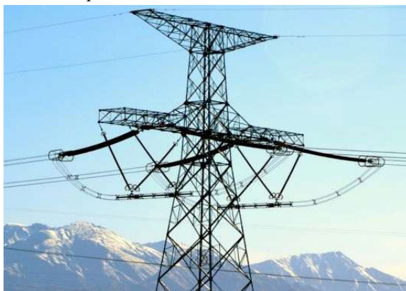
Рисунок 6.1 – Приклад газової (повітряної) ізоляції ЛЕП
